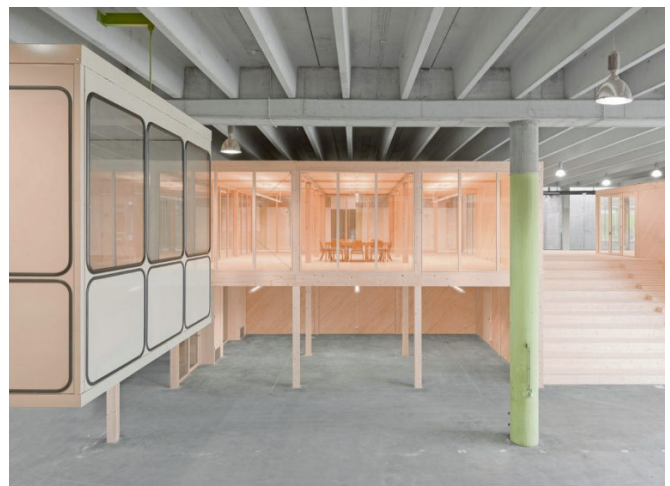
PRAGMATISCH UND GUT. In die offene Tragstruktur wurden neue Räume aus Holz eingestellt.
